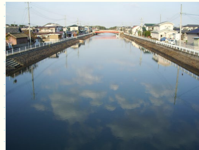
真山運河（荒浜地区） / Teizan Canal (Arahama District) 2007年11月17日 / November 17, 2007 宮城県仙台市若林区 / Wakabayashi-ku, Sendai, Miyagi 工藤寛之 / Hiroyuki Kudo
